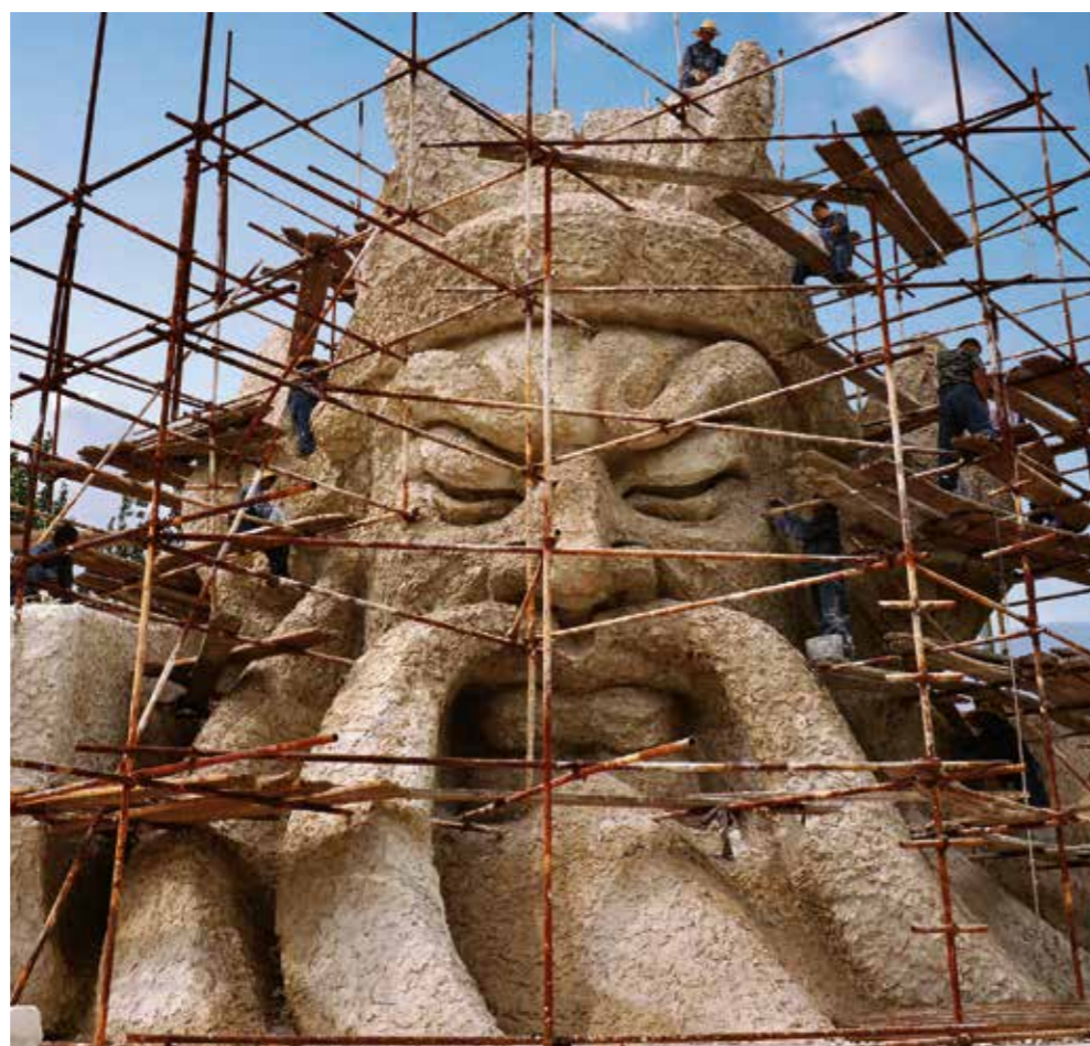
La sculpture urbaine de Han Meilin "Guan Yu" pendant la construction / Han Meilin's city sculpture Guan Yu during construction
